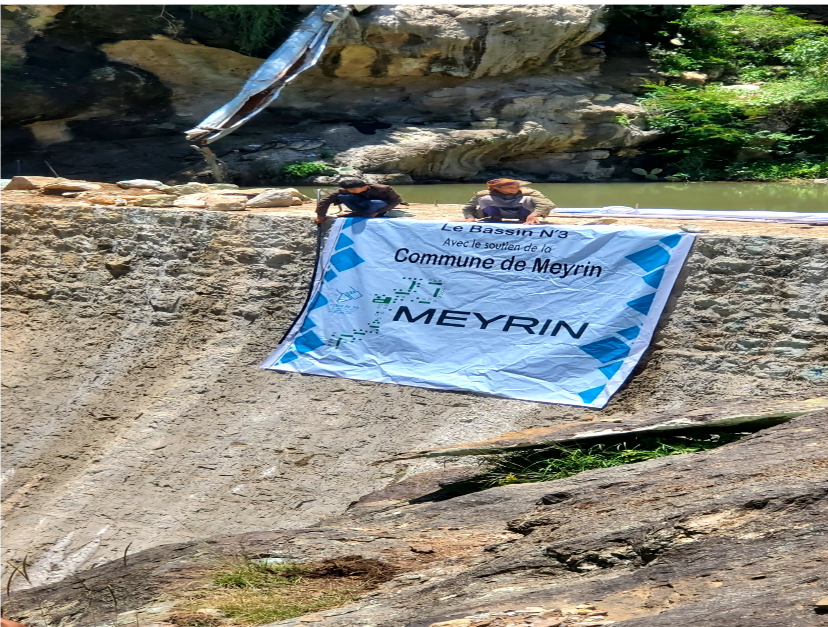
Construction du Bassin n°3 (Février – Décembre 2022)
